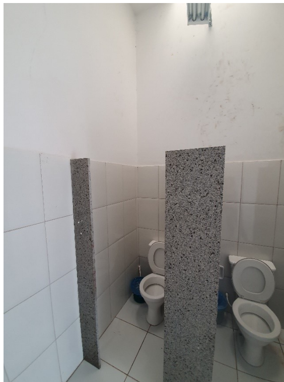
Figura 11 - Bloco 01 - Banheiro Feminino
